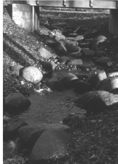
Abb. 3. Oberer Teil der Sohlgleite
